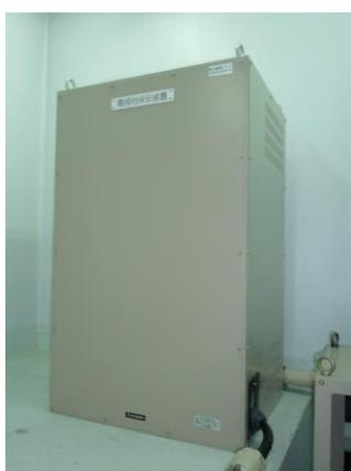
◎耐雷変圧器(電源用保安装置)は、山頂無線中継所等、鉄塔を有する低圧受信設備において鉄塔直撃雷時の電源設備保護を目的としていると同時に、低圧配電側への雷電流放出を極力未然に防止することを目的として使用されます。
